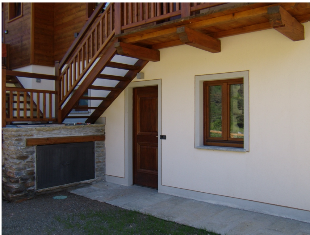
INGRESSO APPARTAMENTO SUB. 33
