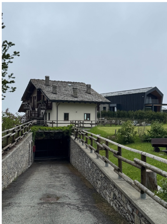
RAMPA ACCESSO GARAGE
